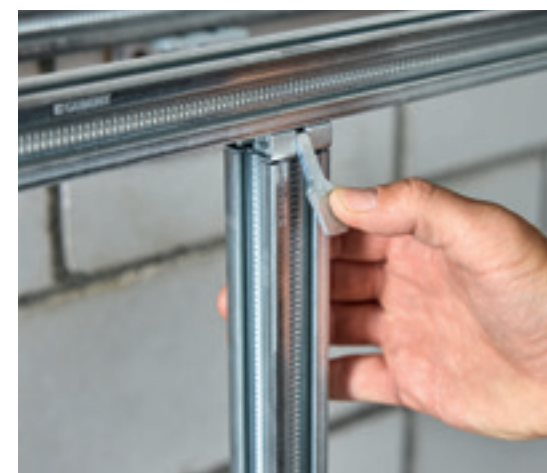
↑ Instalare fără scule cu conectori de profil detașabili.
