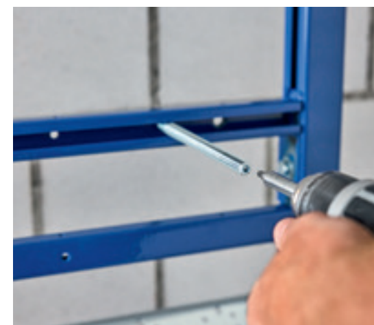
↑ Tije filetate au filete pe toată lungimea, astfel încât acestea pot fi înșurubate la lungimea necesară fără a fi nevoie să le tăiați la lungime. De asemenea, se pot utiliza piulițe mobile cu fantă în T.
