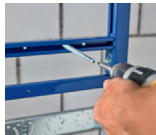
↑ Tije filetate care pot fi înșurubate, chiar și în elementul de lavoar, elimină necesitatea de a le tăia la lungime ulterioar.
